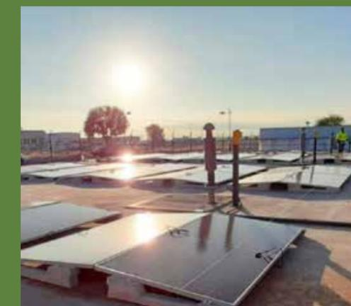
O objetivo deste projeto é reduzir o consumo de energia e a pegada de carbono do processo de tratamento de águas residuais dos moradores da Urbanização El Quiñón através da instalação de painéis fotovoltaicos. As poupanças anuais esperadas situam-se entre 15% e 20% do consumo de energia da ETE.
