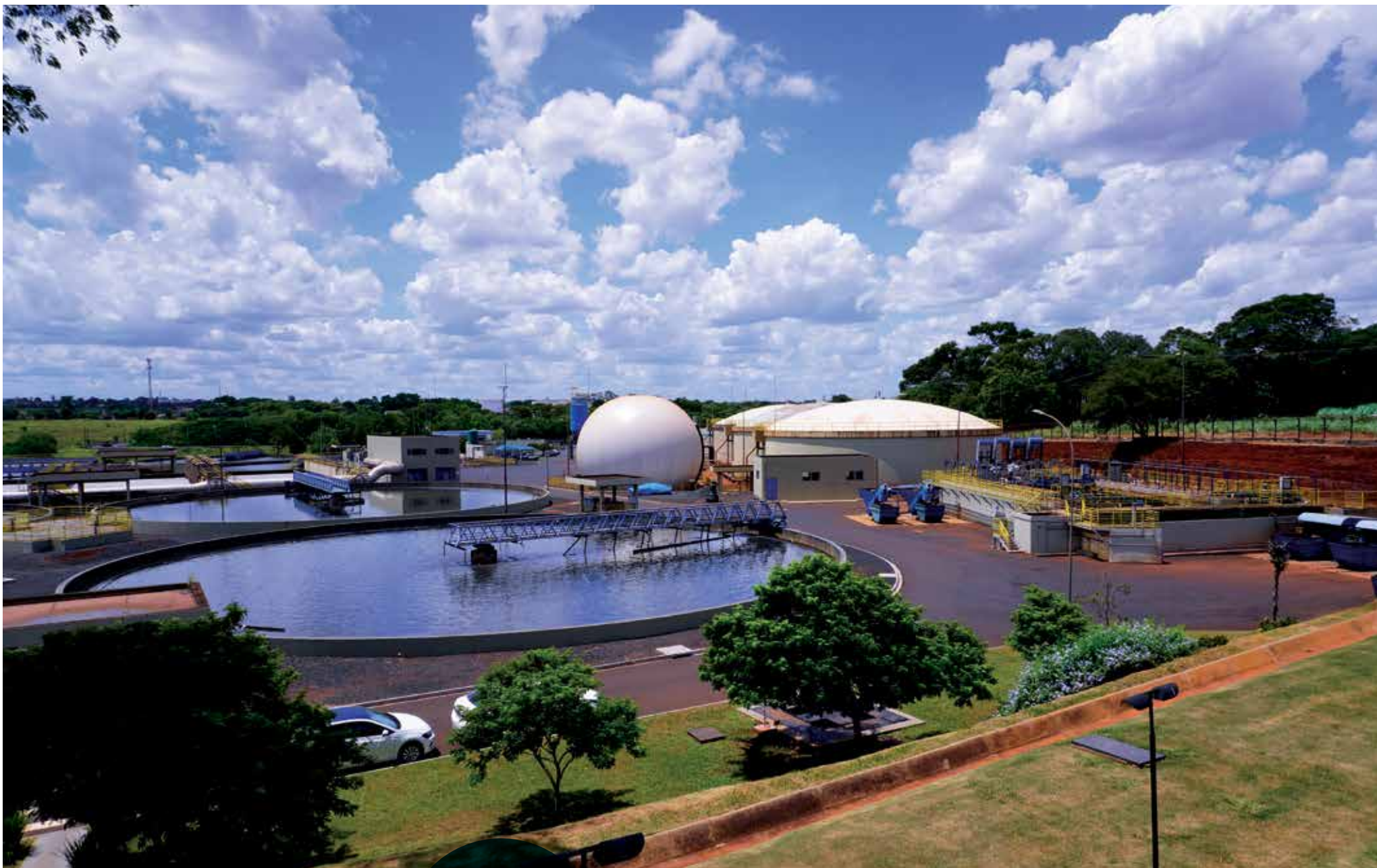
GS Inima AMBIENT - WWTP Ribeiro Preto
