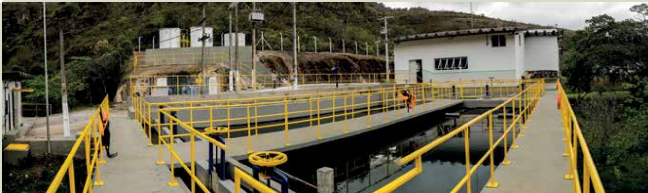
Estação de Tratamento de Água (ETA) Itacolomi. Saneouro – Ouro Preto/MG
